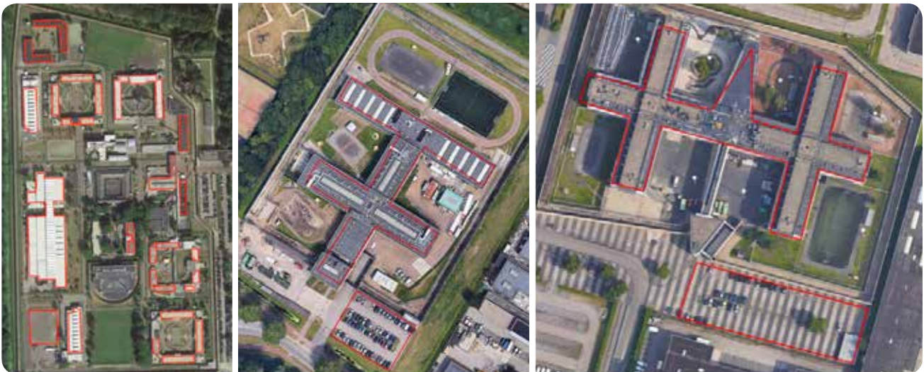
Figuur 12: Het totale oppervlak van, van links naar rechts, PI Vught (29.000 m 2 ), PI Arnhem (5.800 m 2 ) en de PI Nieuwegein (11.450 m 2 ) lijkt voldoende om genoeg elektriciteit op te wekken voor eigen gebruik.
